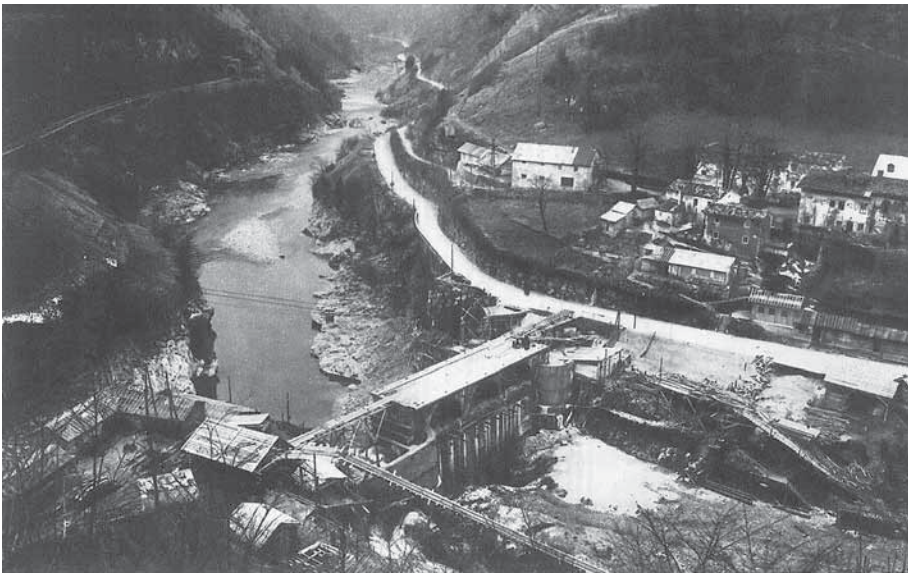
Gradbišče jezu Podselo.
